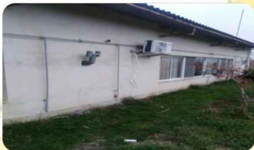
لوله کشی گاز در مرکز رشد جهت نصب بخاری
